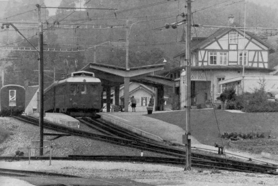
Abb. 25. Die Bahnsteigpartie in der Bergstation Heiden, gesehen mit dem Teleobjektiv. Die Zahnstange läuft bis zum Steigungsbrechpunkt in den Bahnsteiggleisen, so daß das schiebende Triebfahrzeug nicht aus ihrem Bereich ausfährt. Im Vordergrund die Gleise zu Güter- und Lokanlagen.
