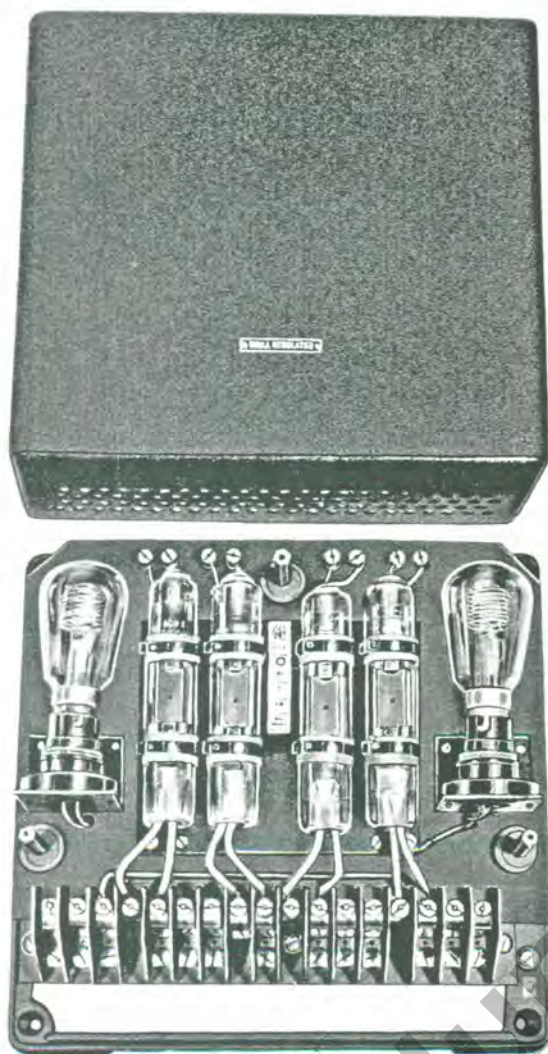
Bild 86 Schützengehäuse, Bauart 1935/36
