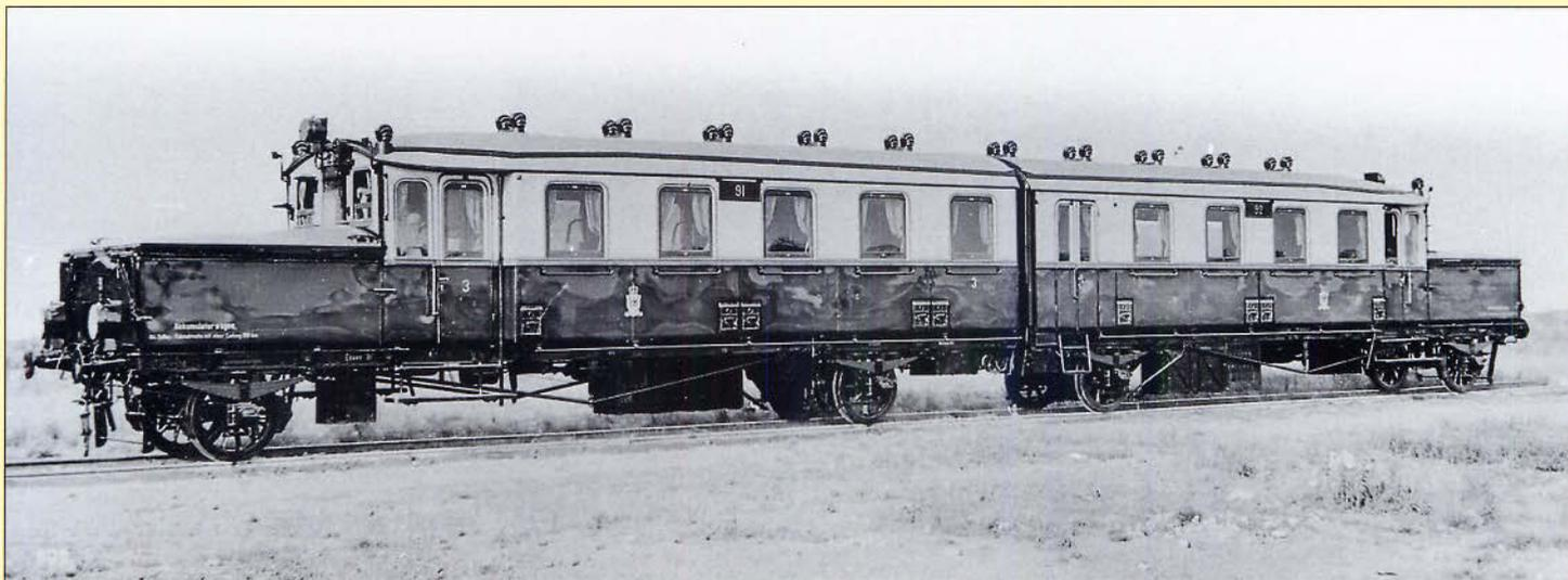
**Bild 138:** Wittfeld-Akkutriebwagen AT 91/92 ESSEN. Der hintere Wagenteil war für die III. Klasse, der rechte für die IV. Klasse vorgesehen. Später erhielt er die Fahrzeugnummer AT 291/292. **Abb.: Sammlung Dr. Scheingraber**
